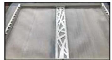
Die mittlere Zahnstange mit der dekorativen Seite nach vorne gerichtet installieren.
