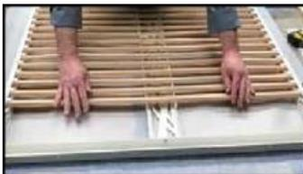
Setzen Sie die Lamellen einzeln in die Zahnstangen ein: Die glatte Dekorseite nach vorne, die Abschrägung nach unten.
